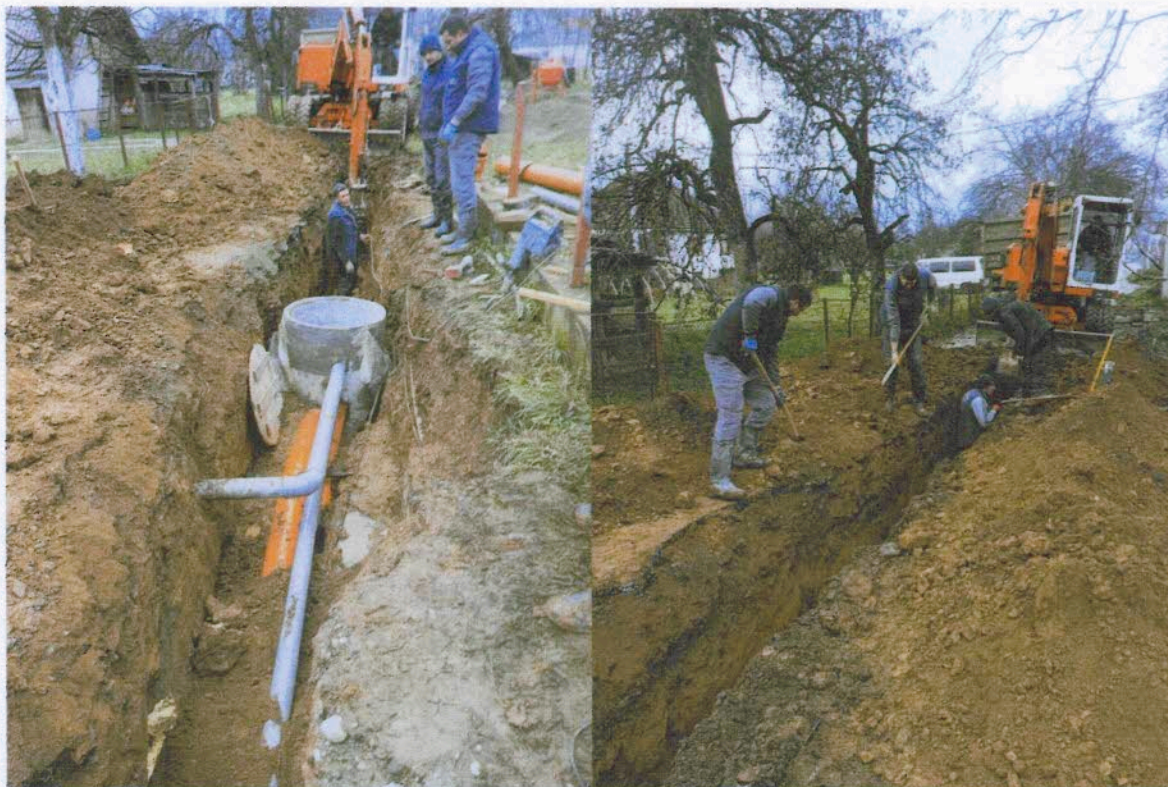
Slike: Izvođenje radova na rekonstrukciji – zamjeni fekalne kanalizacije PVC DN 250 mm u naselju Rasovo – ul. Rasovska
