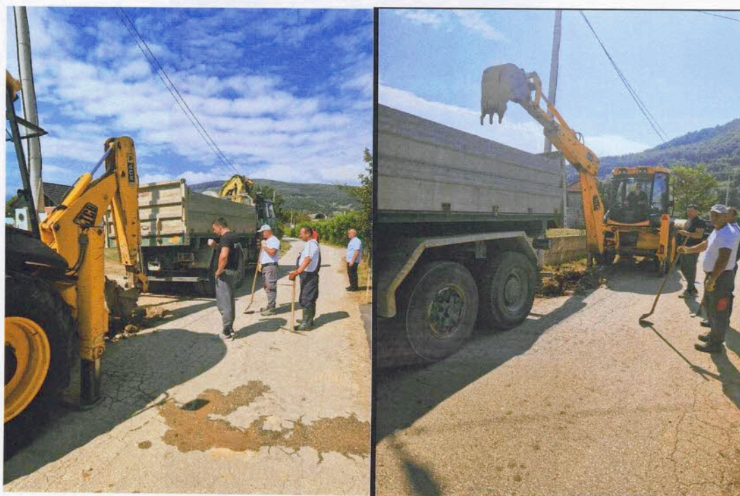
Slika: Izvođenje radova na izradi priključne linije HDPE DN 50mm sa izradom AB šahte za smještaj vodomjera na priključku u naselju Rasovo, ul. Rasovska 2
