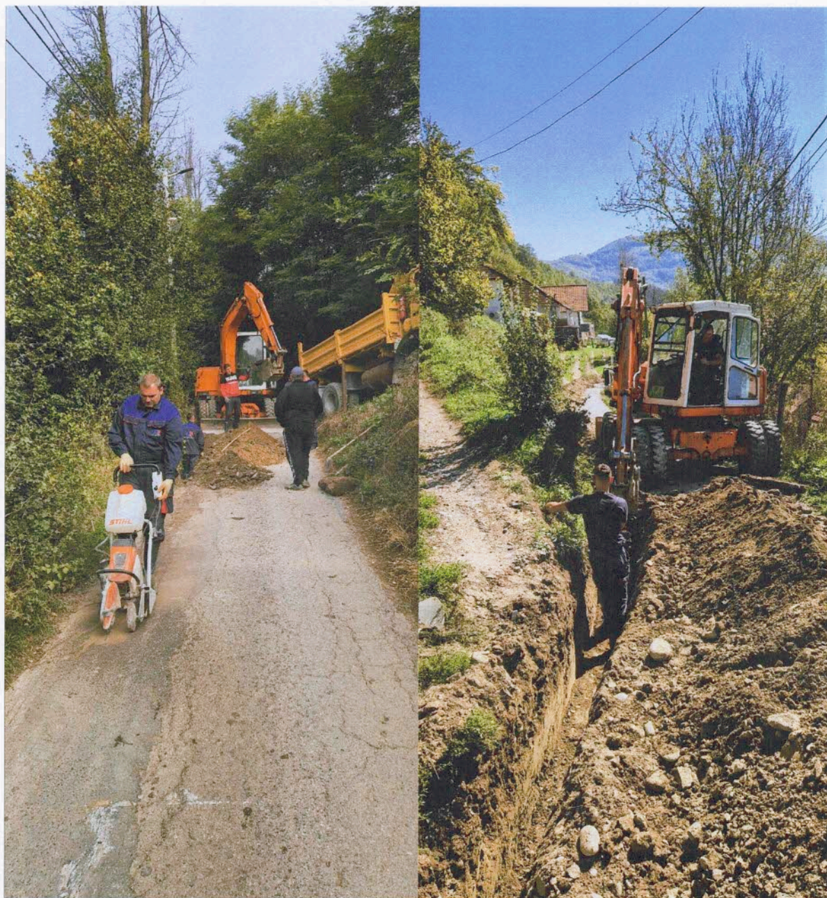
Slike: Zamjena vodovodne mreže HDPE DN 90mm u naselju Lipnica sa zamjenom priključnih cjevovoda HDPE DN 25mm
