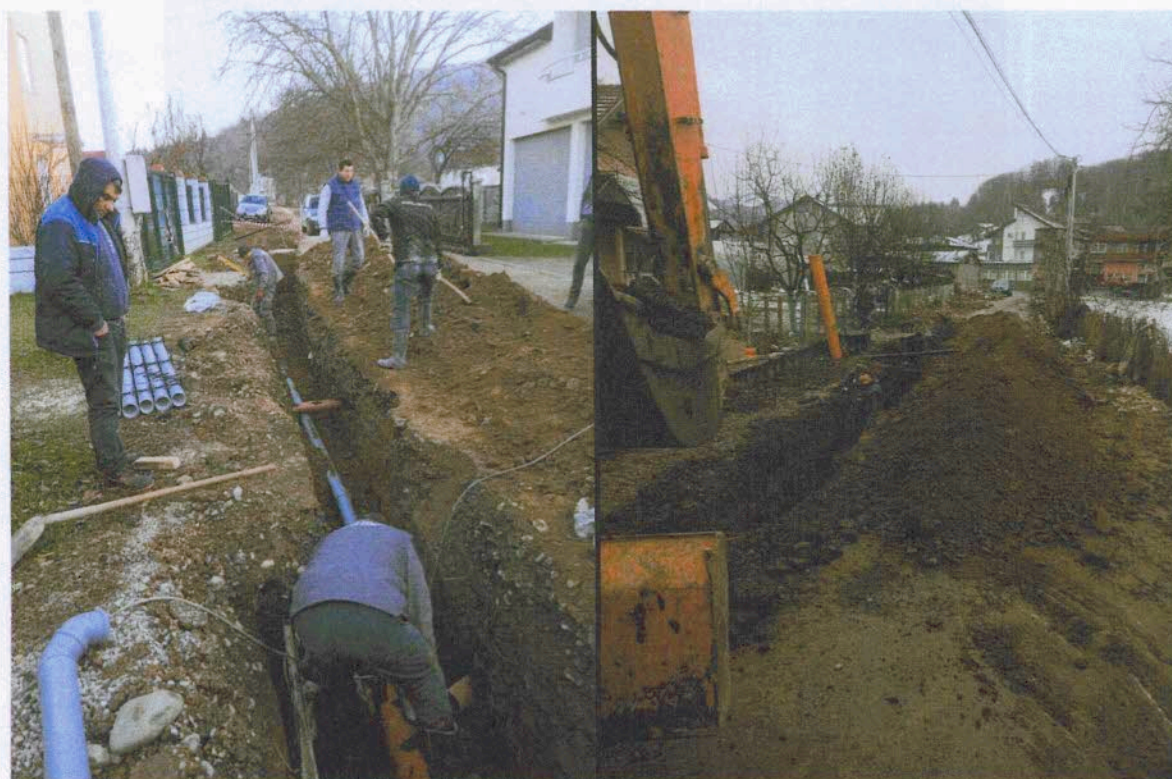
Slike: Izvođenje radova na rekonstrukciji – zamjeni fekalne kanalizacije PVC DN 250 mm u naselju Rasovo – ul. Rasovska
