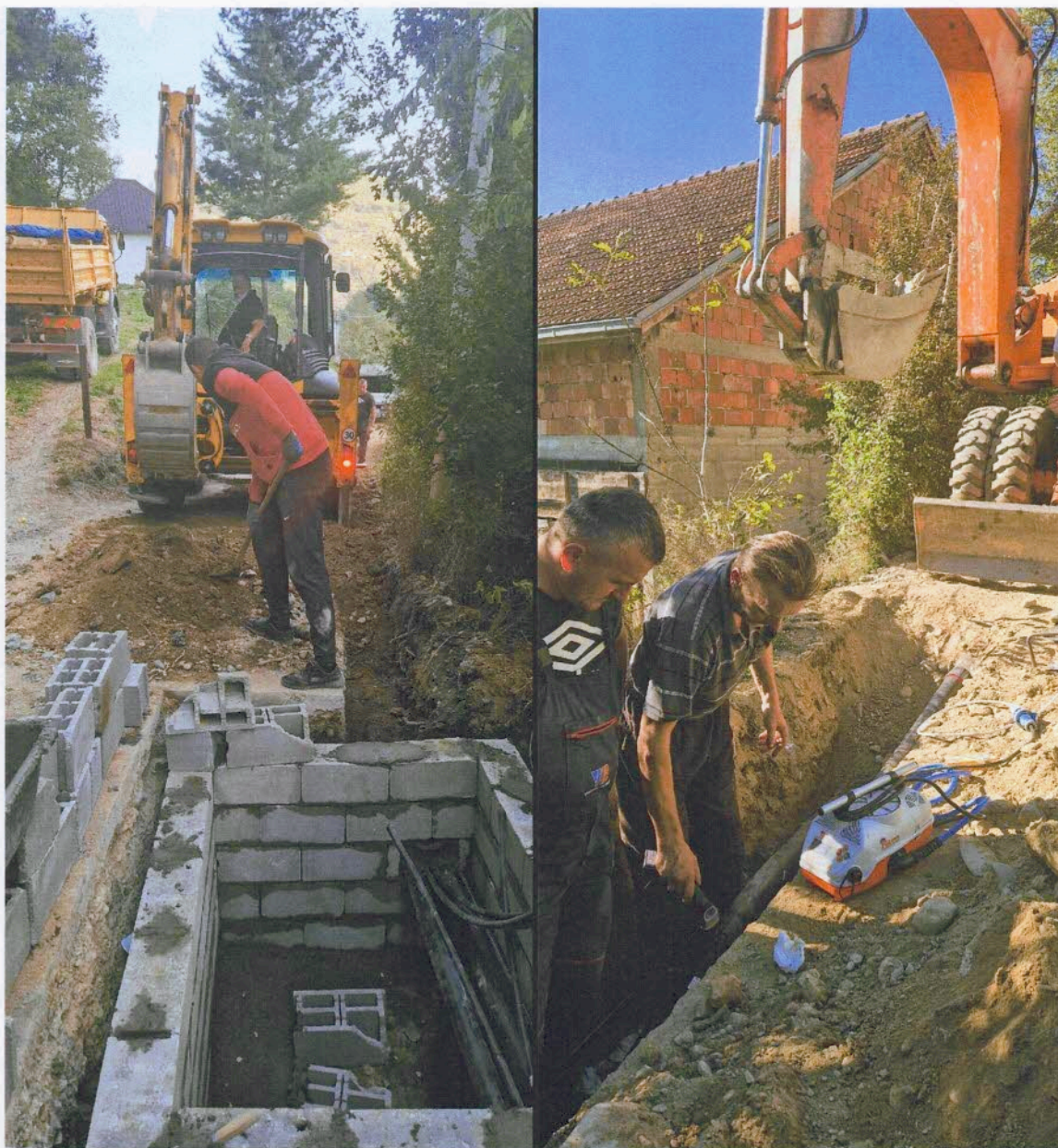
Slike: Zamjena vodovodne mreže HDPE DN 90mm u naselju Lipnica sa zamjenom priključnih cjevovoda HDPE DN 25mm i šahti za smještaj vodomjera na mjestu priključenja potrošača
