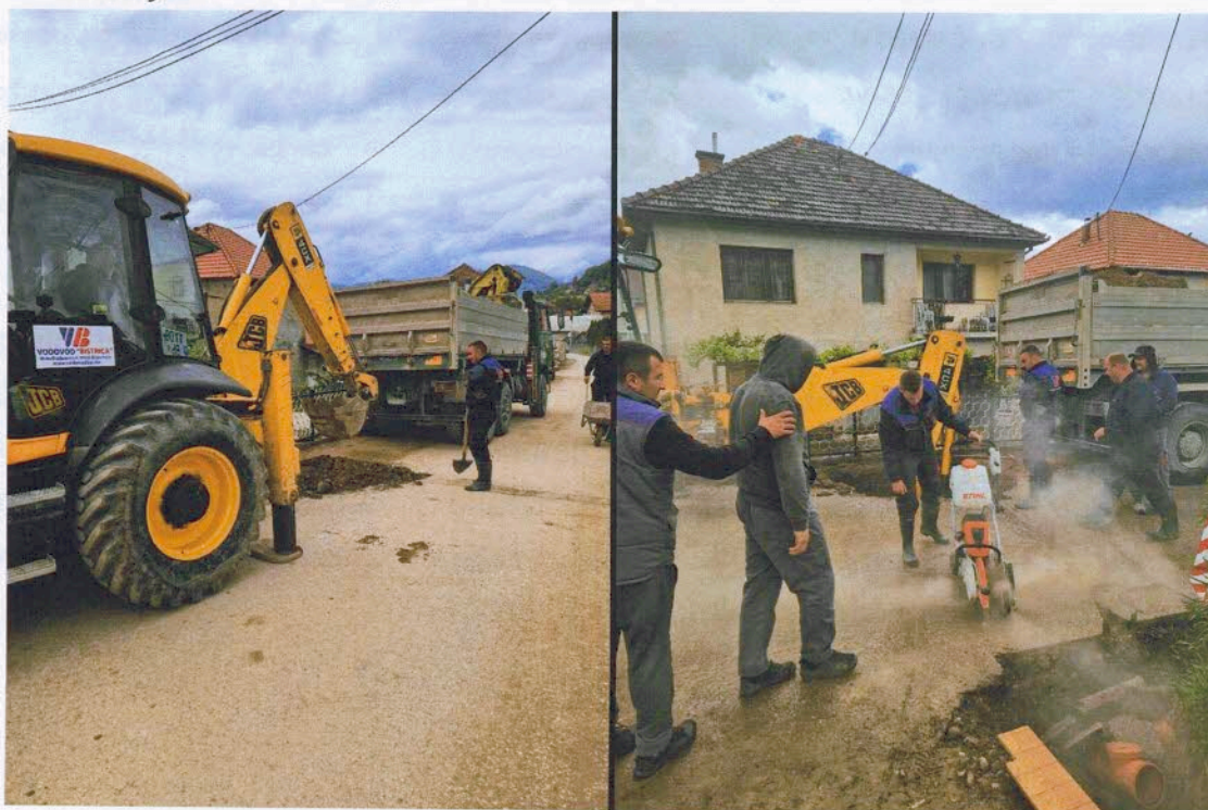
Slike: Sanacija kvara na vodovodnoj liniji ACC DN 100 mm u mjestu Nedakusi, ulica Ćamila Sijarića, sa izradom AB šahte na mjestu priključenja više domaćinstava.
