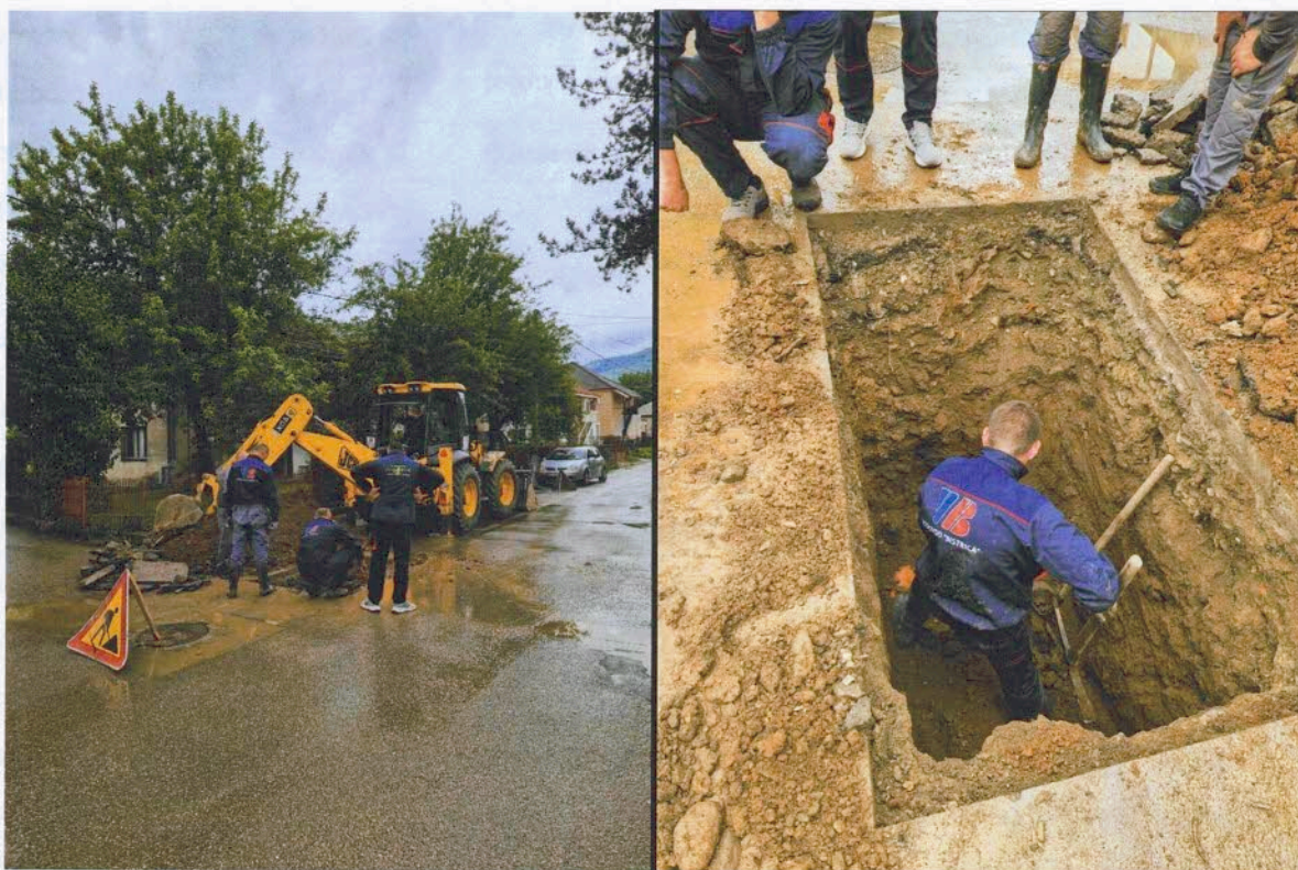
Slike: Sanacija kvara na vodovodnoj liniji ACC DN 100 mm u mjestu Nikoljac, ulica Neđeljka Merdovića, kod OŠ Risto Raković.
