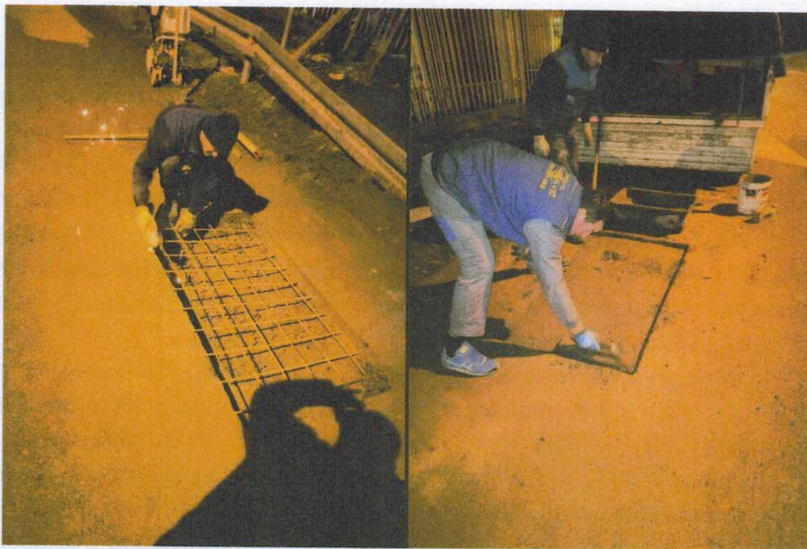
Slike: Betoniranje i armiranje na mjestima gdje je otklonjen kvar na vodovodnoj mreži
