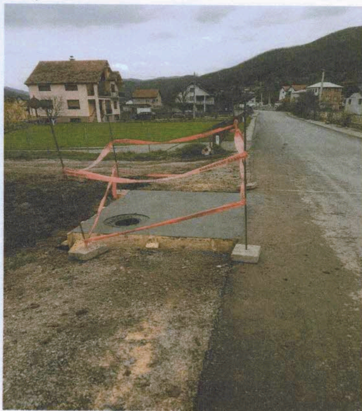
Slike: Izrada AB šahte na mjestu priključenja više korisnika u naselju Rasovo
