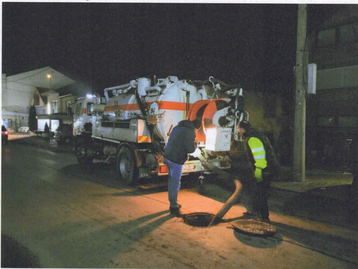
Slika: Steyr cistjerna za odgušenje i crpljenje kanalizacije, prilikom odgušenja - ispiranja kanalizacije u centru grada kod Čevapdžinice „Senčo“
