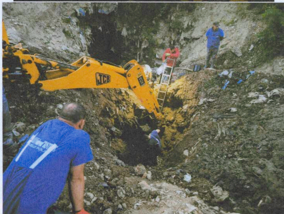
Slika: Sanacija glavnog vodovoda ACC DN 300mm
