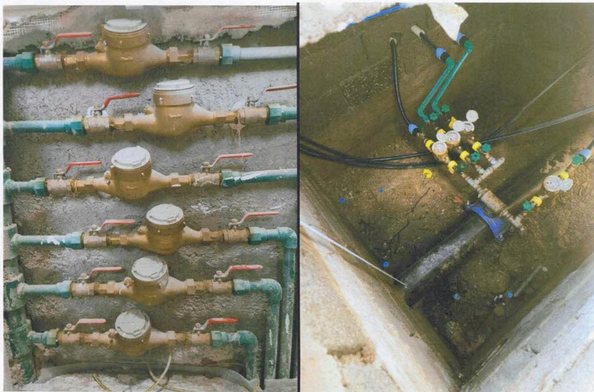
Slika: Fotografija sa terena prilikom zamjene i plombiranja vodomjera
