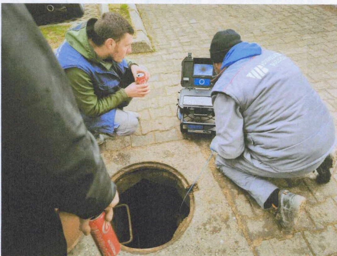
Slike: Rad radnika na kontroli prohodnosti fekalnog kolektora PVC DN 250mm pomoću ispitne kamere za kanalizaciju
