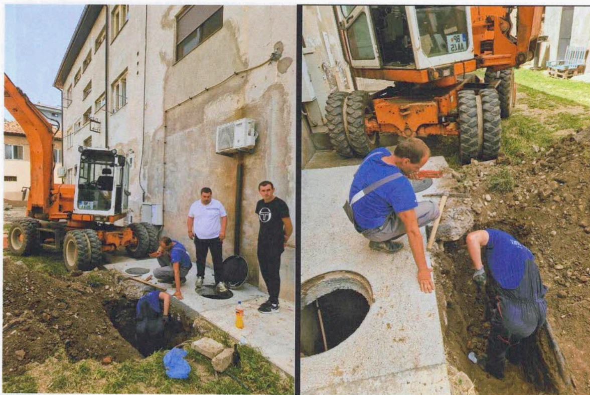
Slike: Popravka kvara na priključnoj liniji za stambeno – poslovnu zgradu „Bela vista“ u ul. Slobode
