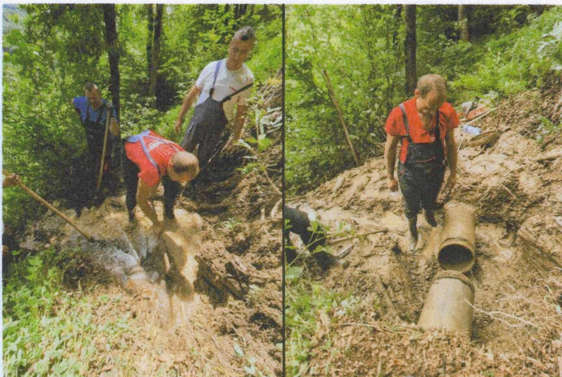
Slike: Sanacija kvara na vodovodnoj liniji ACC DN 300 mm u mjestu Ravna Rijeka, iznad magistralnog puta Bijelo Polje – Mojkovac.
