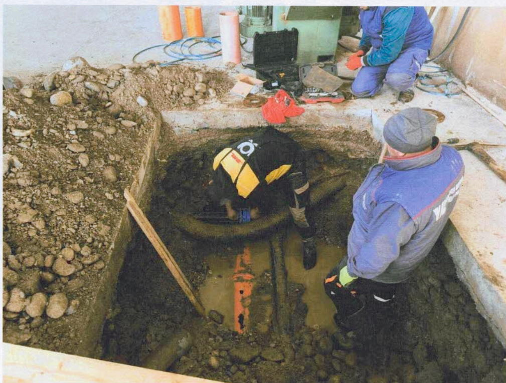
Slike: Popravka kvara na priključnoj liniji za stambeno – poslovnu zgradu „Lux“ u ul. Živka Žižića sa sanacijom kanalizacione cijevi PVC DN 250mm
