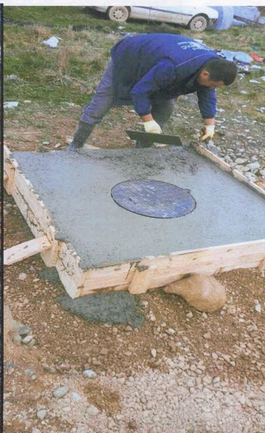
Slika: Izrada šahti na mjestima ugradnje glavnih zatvarača na sekundarnim linijama u mjestu Nedakusi i Lipnica
