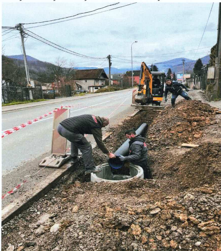
Slika: Izmještanje atmosferske i fekalne kanalizacije DN 300mm kod Okova
