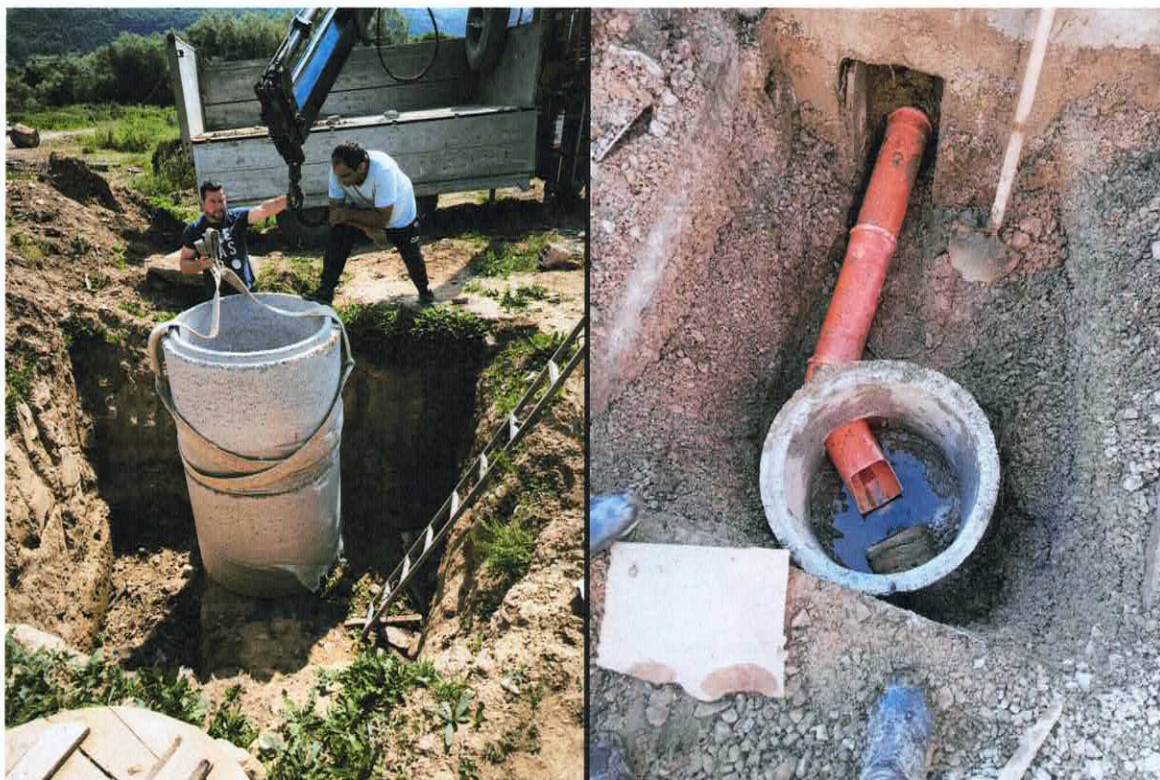
Slika: Izrada revizionih šahti na fekalnoj kanalizaciji
