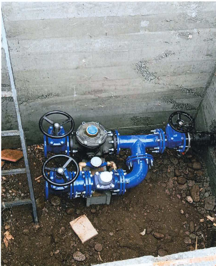
Slika: Fotografija sa terena prilikom zamjene i plombiranja vodomjera
