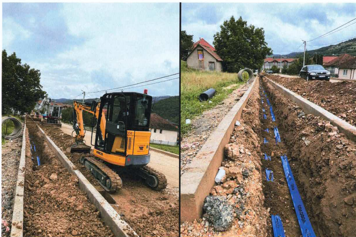
Slike: Izmještanje vodovoda HDPE110mm sa izmještanjem vodomjera u šahte
