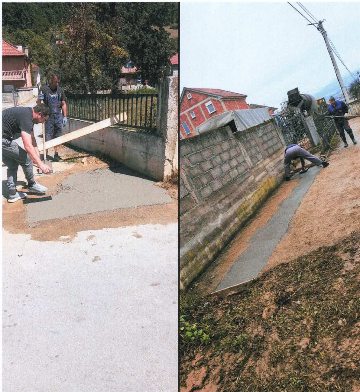
Slika: Betoniranje kvarova nakon sanacije vodovodne i kanalizacione mreže
