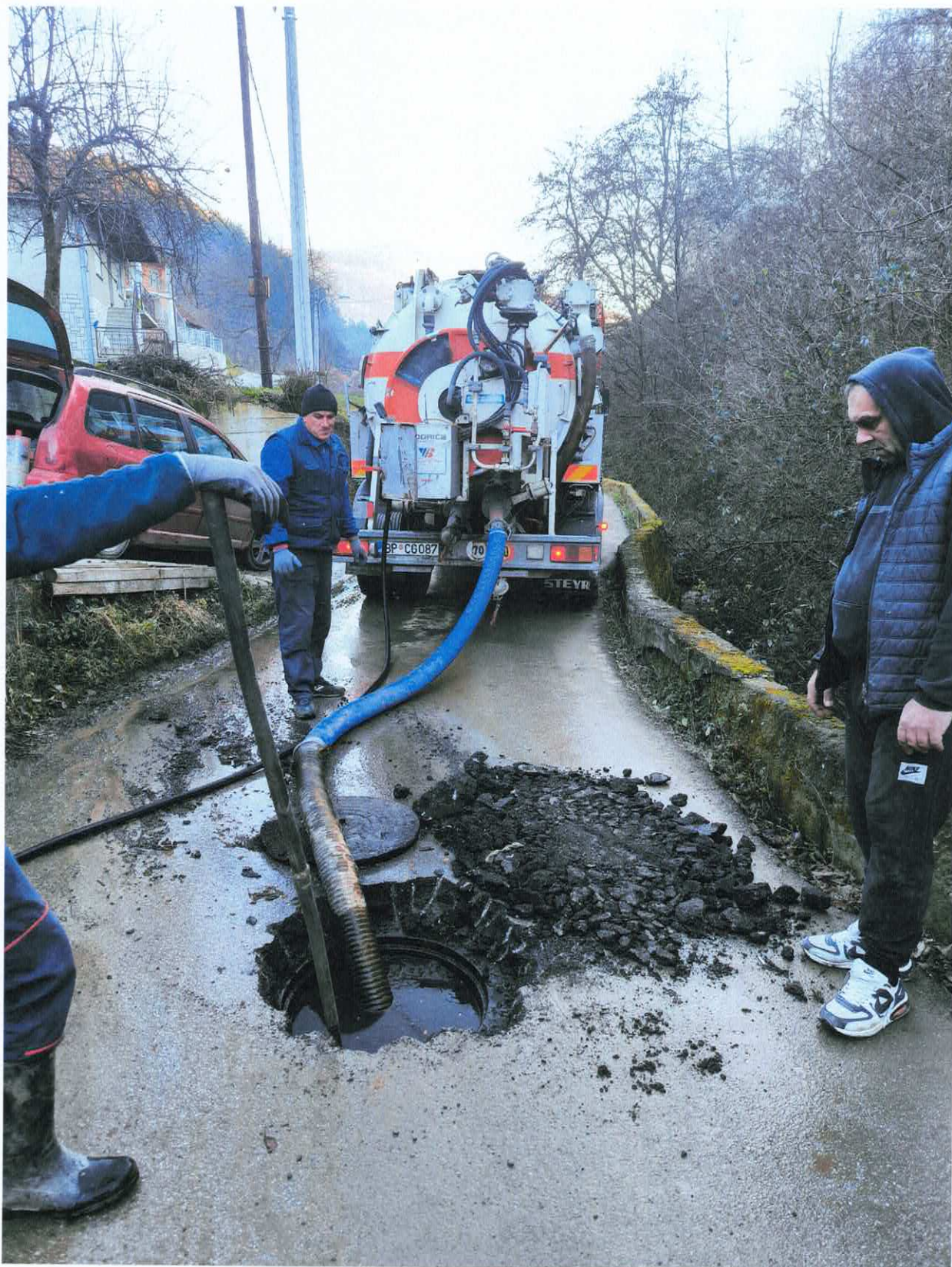
Slika: Sanacija fekalne kanalizacije u naselju Lipnica po zahtjevu MZ „Lipnica“
