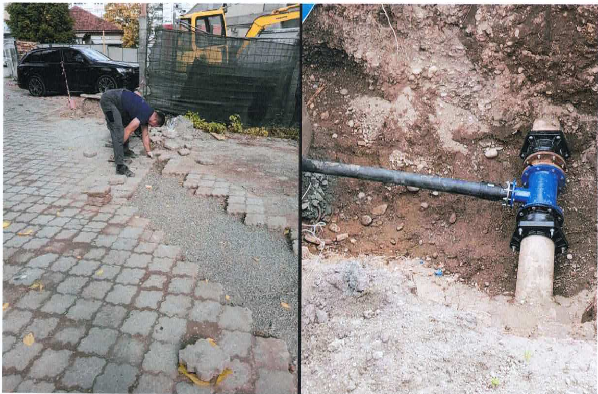
Slika: Sanacija kvara na ACC f1 100mm i vraćanje behaton ploča
