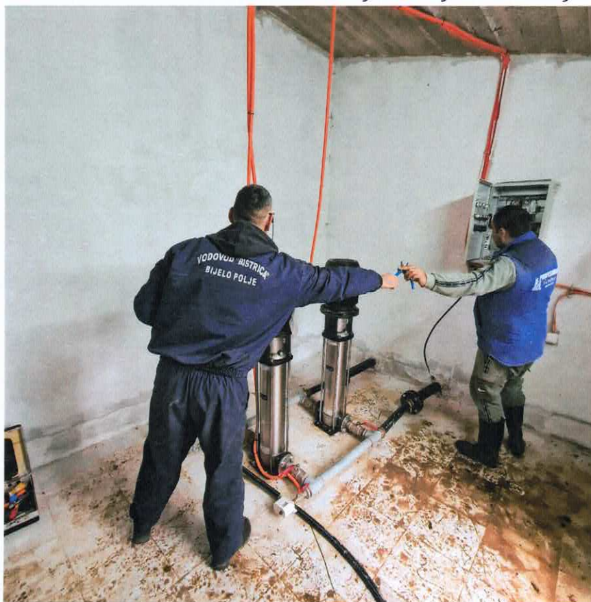
Slika: Sanacija pumpe u pumpnoj stanici „Medanovići II“
