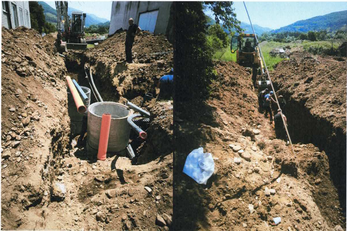
Slika: Sanacija postojeće fekalne mreže kod Vunarskog kombinata
