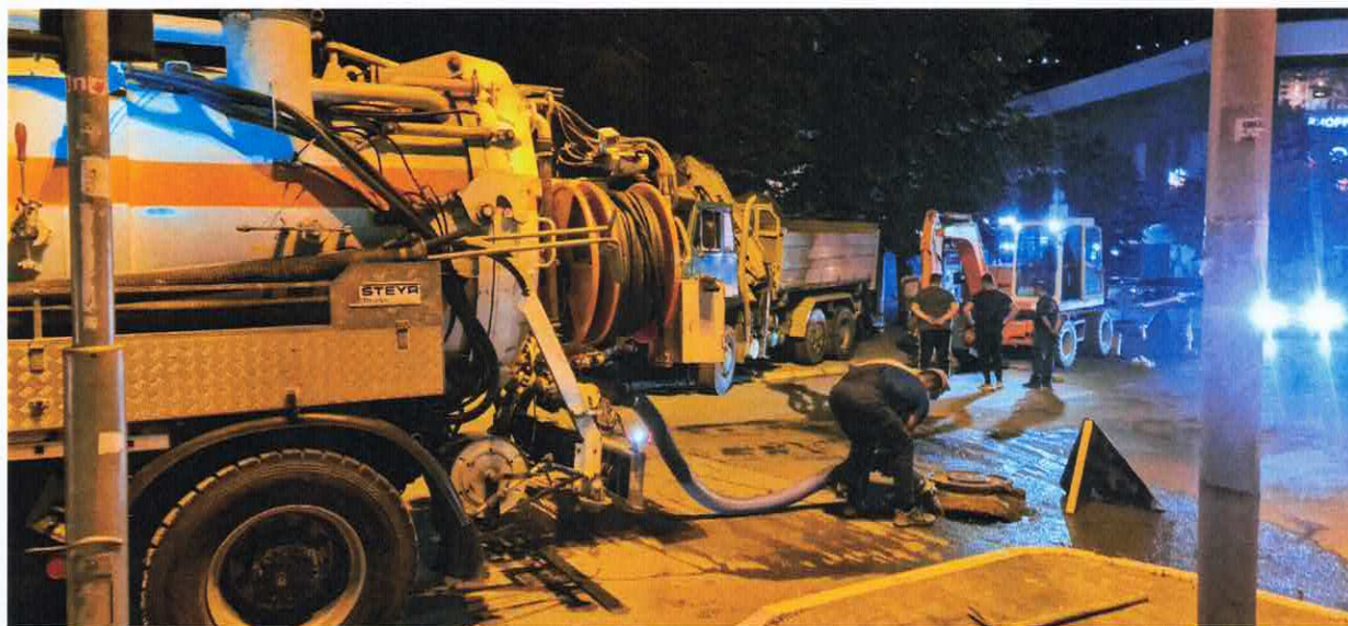
Slika: Steyr cistjerna za odgušenje i crpljenje kanalizacije, prilikom odgušenja -ispiranja kanalizacije u centru grada raskrsnica ul.III Sandžačke i ul.Slobode
