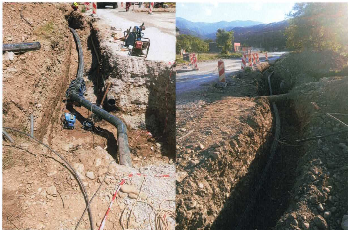
Slike: Izmještanje glavnog vodovoda HDPE 200mm u naselju Zaton
