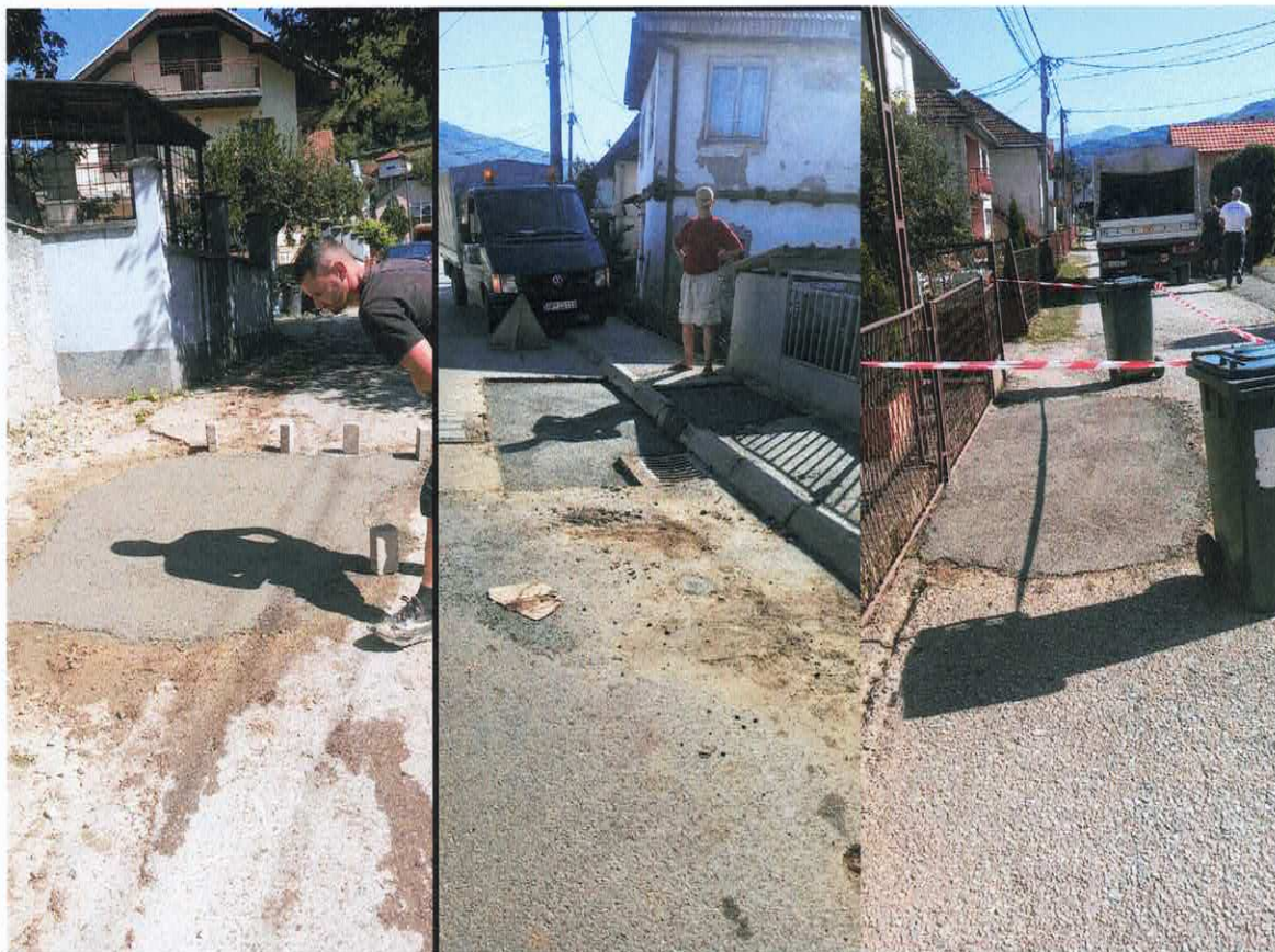
Slika: Betoniranje kvarova nakon sanacije vodovodne i kanalizacione mreže
