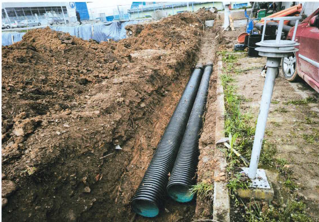
Slika: Izmještanje atmosferske i fekalne kanalizacije DN 300mm kod Okova
