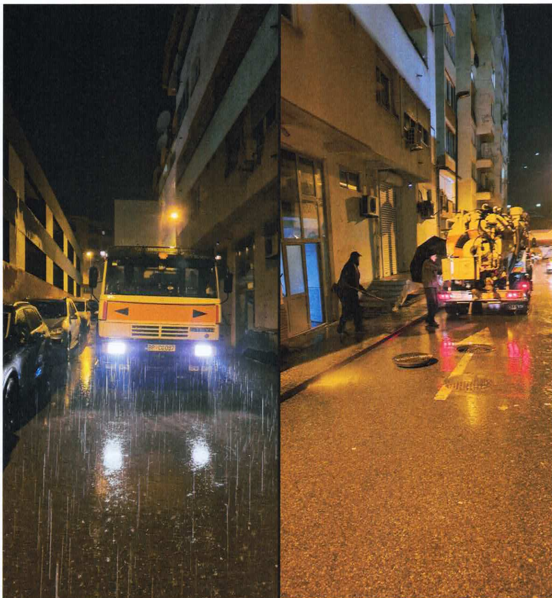
Slike: Rad radnika na odgušenju fekalnog kolektora DN 250mm kod gradske garaže u ul. Živka Žižića
