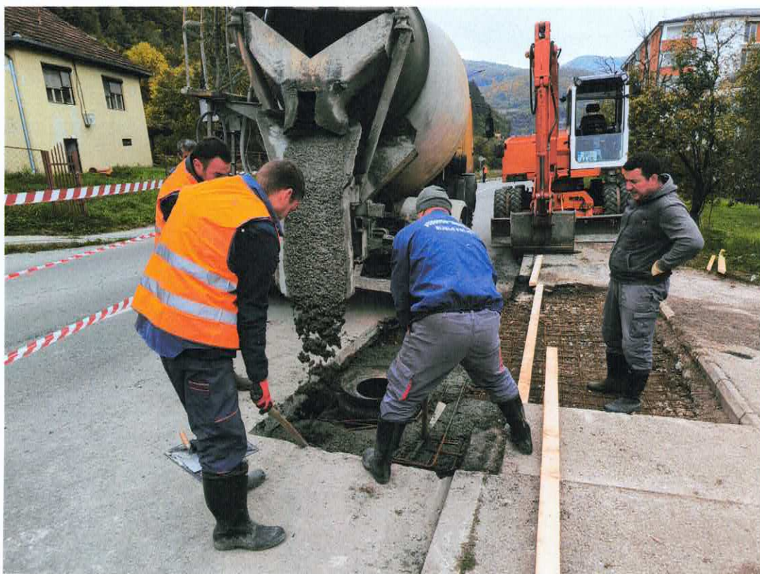
Slika: Betoniranje kvarova nakon sanacije vodovodne i kanalizacione mreže
