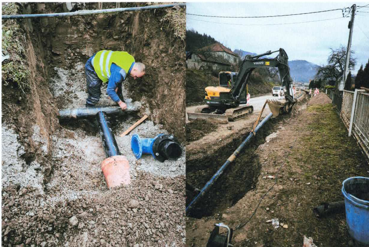
Slike: Izmještanje glavnog vodovoda HDPE 200mm u naselju Zaton
