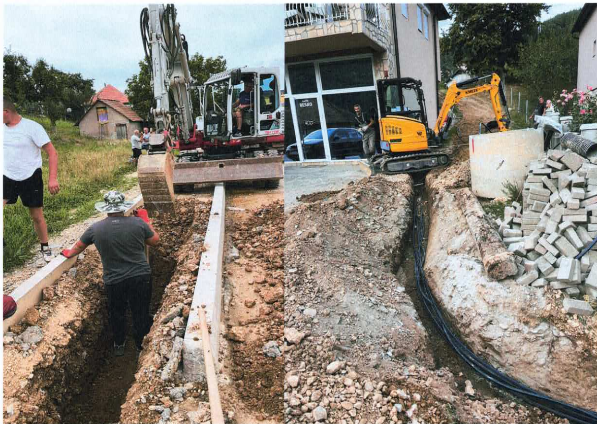
Slike: Izmještanje vodovoda HDPE110mm i priključnih linija–naselje Gubavač
