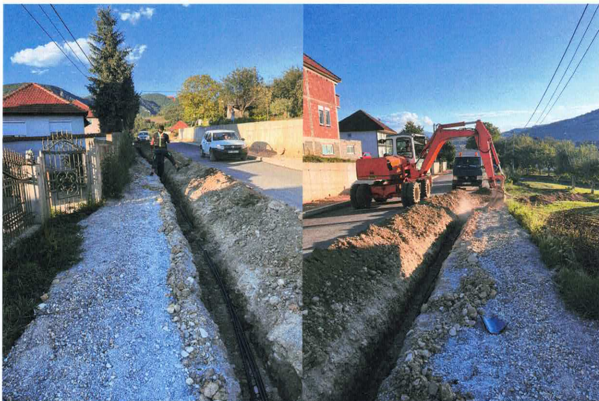
Slike: Izmještanje vodovoda HDPE110mm i priključnih linija–naselje Gubavač
