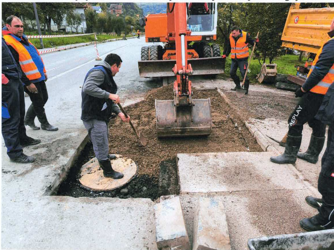
Slika: Sanacije fekalne kanalizacije u naselju Nikoljac – Rogojevići
